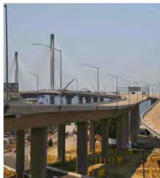
Juan Antonio Paz. Gerald Desmond Bridge, Los Angeles (USA).
